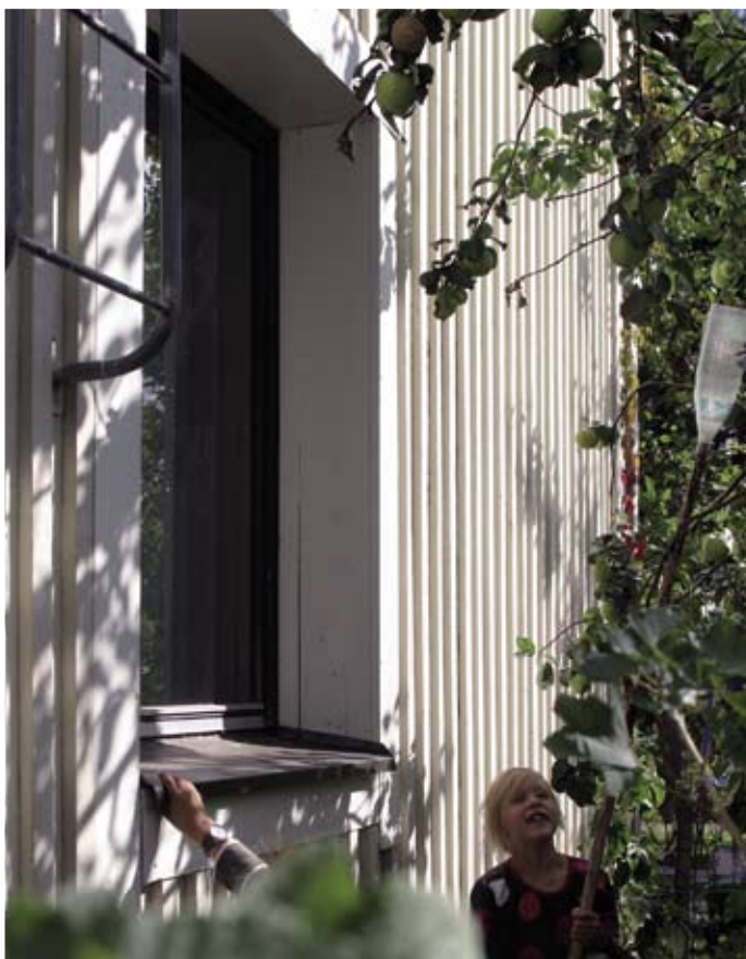
Palotikkaat asennetaan niin korkealle, että lapset eivät pääse helpolla kiipeämään. Myös alempien puolien poistaminen vaikeuttaa kiipeilyä.
